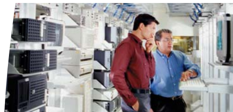
Intégration dans les racks à haute densité.
