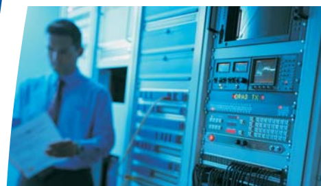
Serveurs, Stockage et équipements réseaux.
