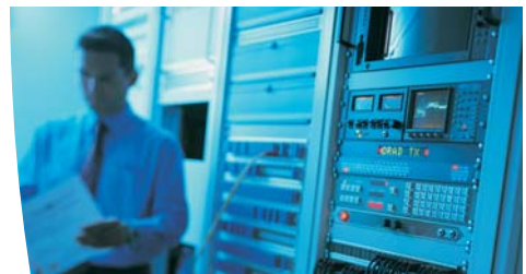
Intégration dans les racks haute densité.
